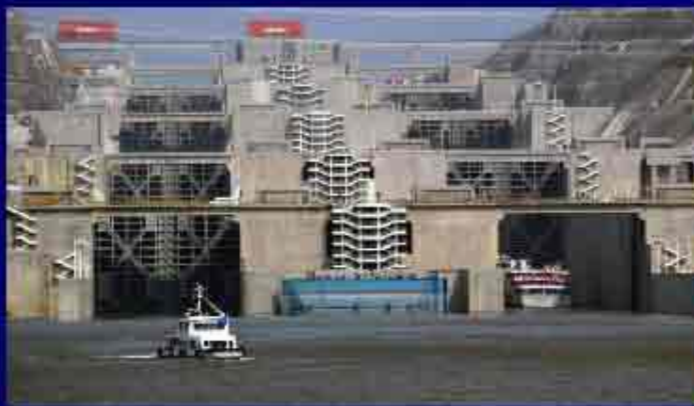
三峡五级船闸
