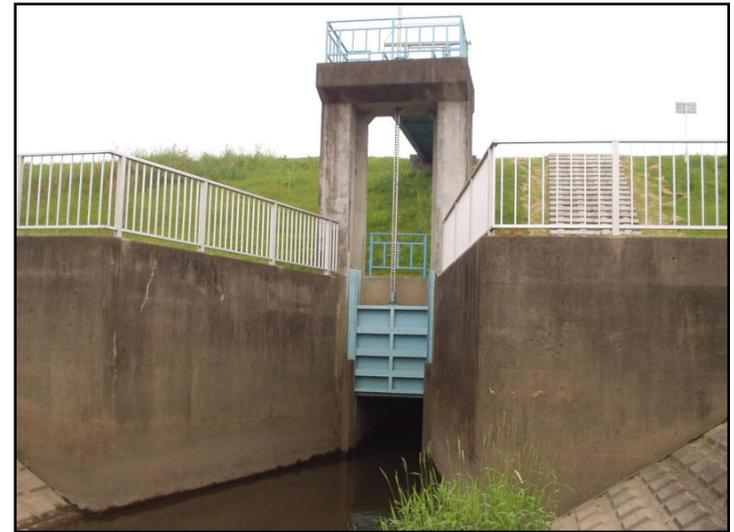
洪水时应该关闭的闸门(水闸/大型涵管等)
